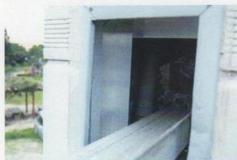
スライディングルーフ(移動屋根)式の観測室ですから、レールと屋根との間には隙間があります。そこから雨水や小鳥などが侵入しないよう、建設当初はゴム製の遮蔽板が取り付けてありました。しかし、生ゴム製でしたから風雨や紫外線にいつまでも耐えられるわけではなく、17年の間にその大半がボロボロになっていました。
