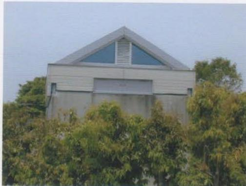
左の写真（上）が外から見た移動屋根の開口部分。普段は鉄製のドアが閉まっていて、屋根をスライドさせる際には室内側に開いて望遠鏡をかわしています。
