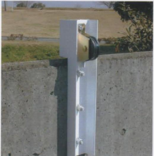
の方ではまず、重量戸車を購入し寸法測定。次いで鉄骨加工のために近所の整備工場へ行きポール盤などの工具を使わせて頂くよう交渉しました。
