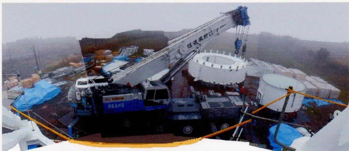
組立中の電波望遠鏡 3月には完成の予定だそうです 中央は大型 160t クレーン
